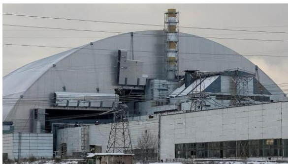
Fig. 19 Sarcòfag de formigó i acer construït sobre la central nuclear de Chernobil
